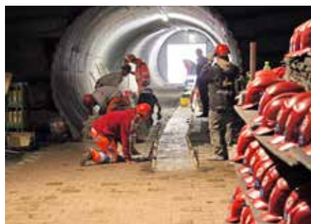
Beim Pflastern des Zugangsstollens.
