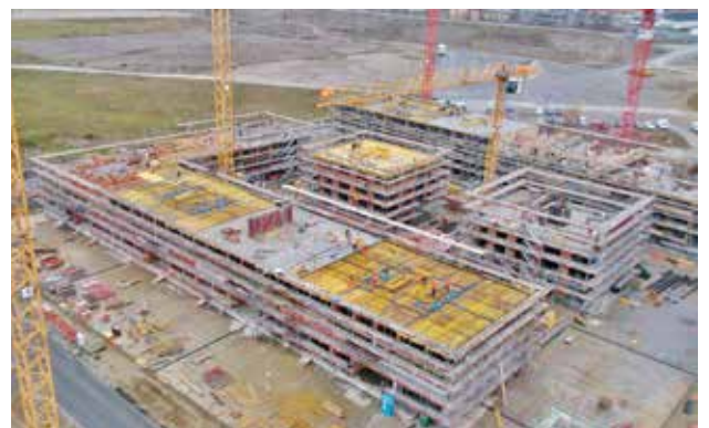
Der Rohbau des ersten Baufelds in Olten Süd-West mit rund 420 Wohnungen wurde im Frühjahr 2015 fertiggestellt.
