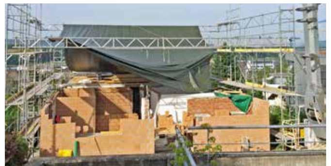
Abbruch des Schrägdachs und Neubau eines Flachdachs.
